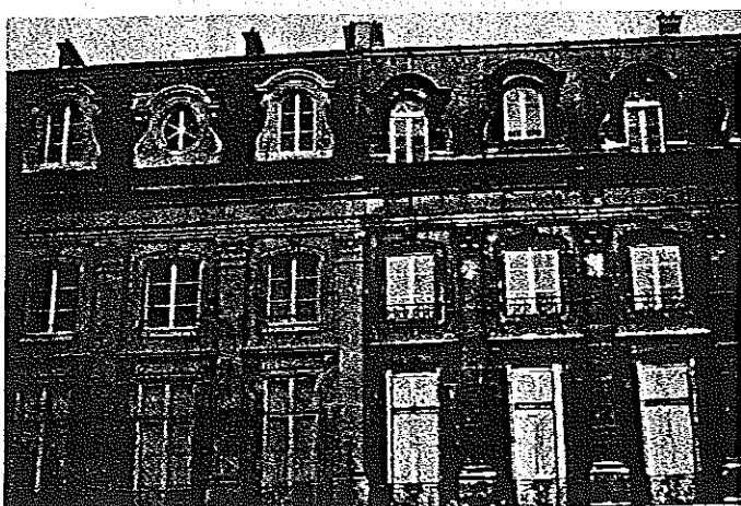
Façade en pierres de taille calcaires en cours de nettoyage.
