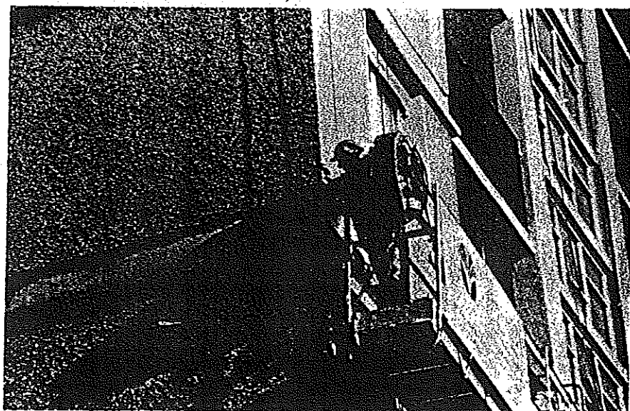
Fig. 4 - Traitement d'un bandeau béton par un procédé d'étanchéité armé d'un textile.
